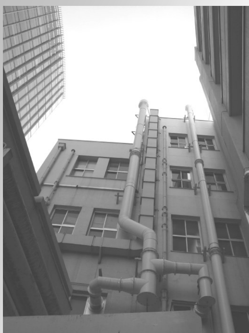
個別ドラフターの新設
