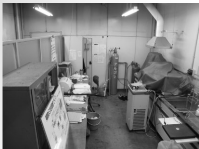
排水施設管理・分析室の改修
