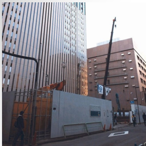
南棟(仮称)建設工事中の6・9号館跡地
