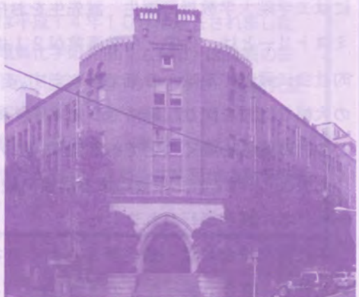
撮影：旧1号館 建築学科 大川三雄先生
