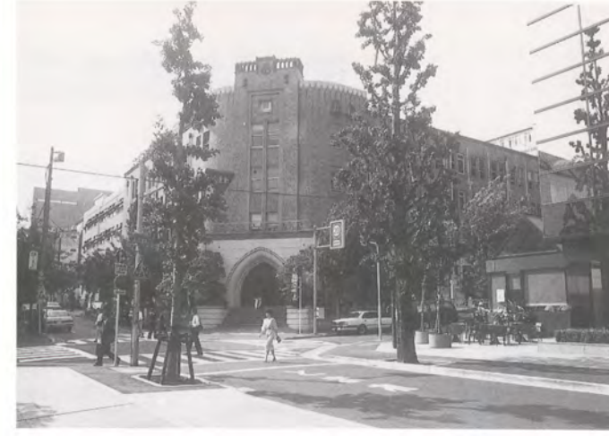
昭和63年の1号館
