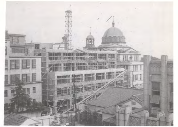
理工学部4号館建設中
