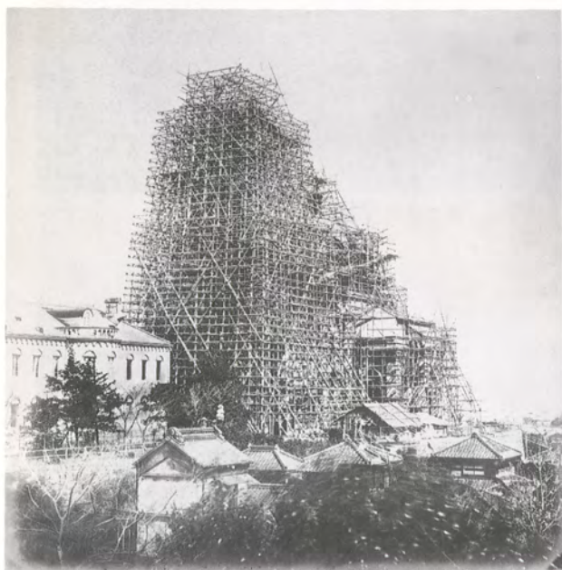
明治22年ニコライ堂の建築現場 (ジョサイヤ・コンドルの設計) (富士銀行お茶の水支店提供)
